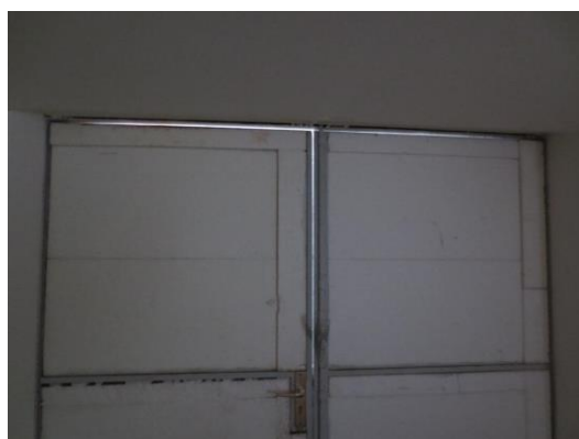
Derzeitige Tür von innen und außen
