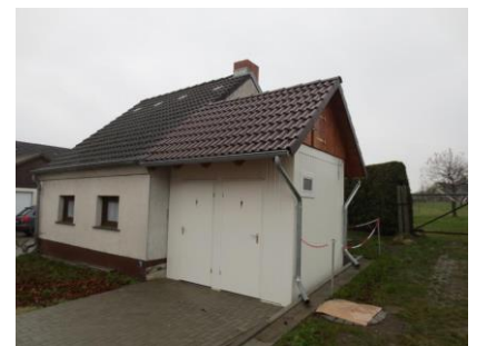
Toilettenanbau mit Wasserversorgung
